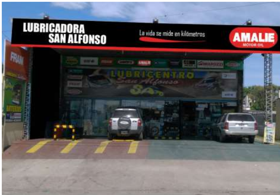
Figura 43. Fachada de lubricadora
