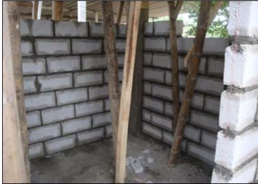
Figura 6-5 Paredes dentro del cuarto de equipo
