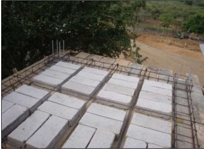
Figura 6-3 Construcción de loza para el cuarto de equipo
