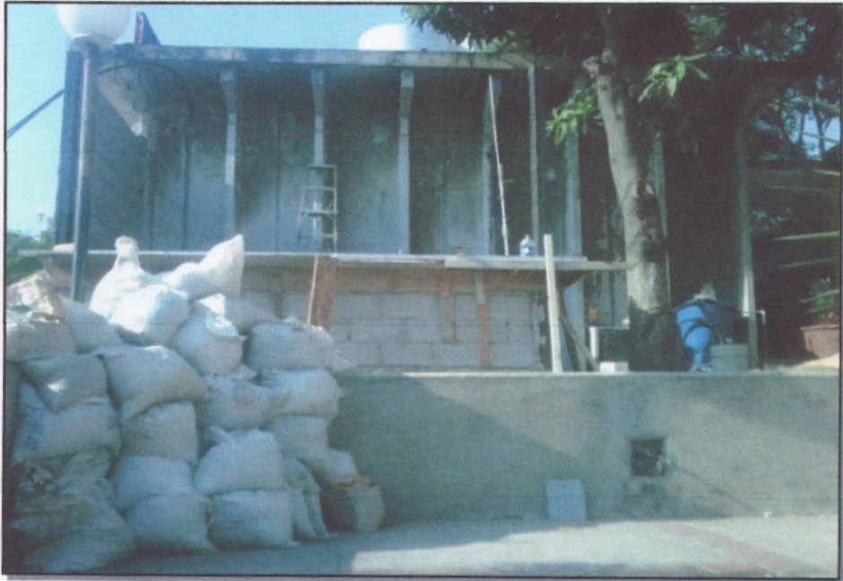
Fotografía N° 1. Vista frontal del avance de construcción.
