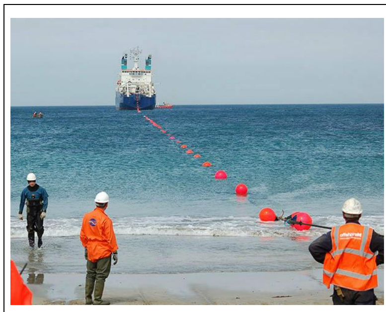
Figura 3.25 Tendido del cable submarino desde la estación terminal
