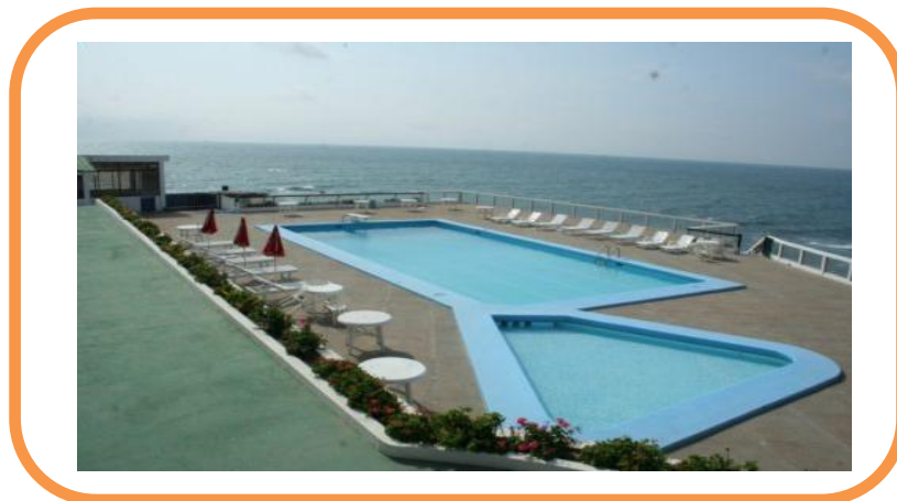
FIGURA 1.3 Piscinas del Hotel
