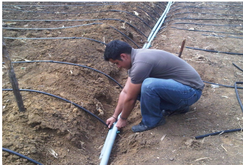
Foto 2. Instalación de sistema de riego
