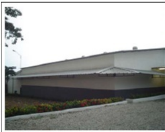
Fotografía 27. Vista del área ampliada de la Bodega de Producto Terminado
