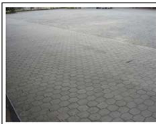
Fotografía 3. Area adoquinada del Andén de Carga y Descarga.
