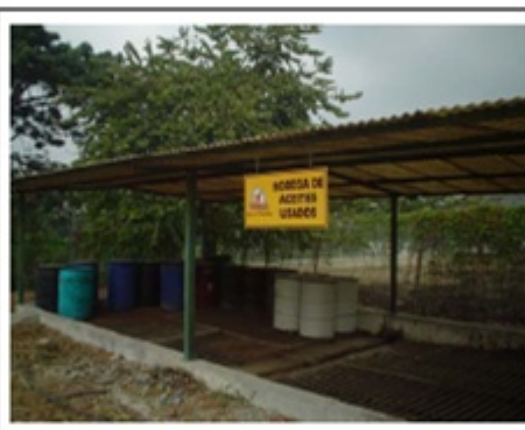
Fotografía 22. Bodega de Aceites Usados (lubricantes y vegetales).
