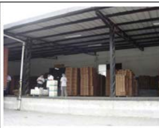
Fotografía 2. Vista del andén de Carga y Descarga.
