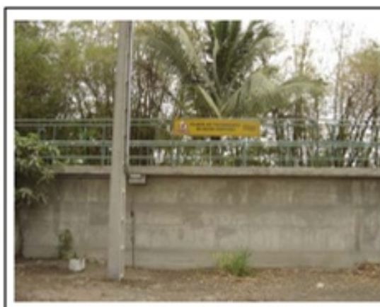
Fotografía 23. Vista de la planta de tratamiento de aguas residuales.
