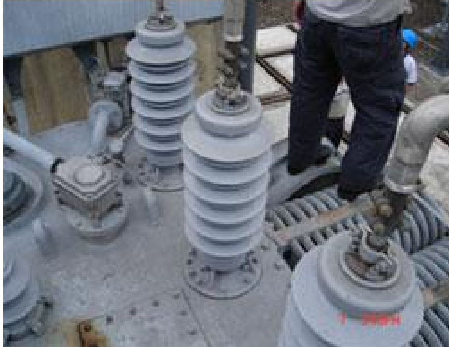
FIG. 2.3.7.1 PASA TAPAS (BUSHINGS)
