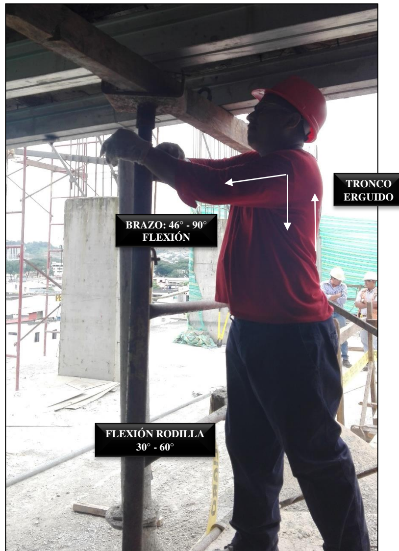
Foto 14. Desencofrado de viga de HA.
