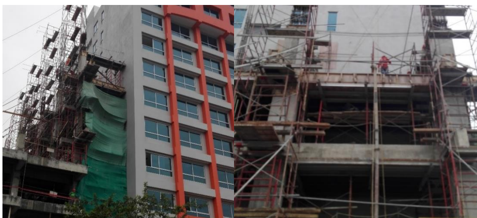
Foto 2. Construcción de las losas.
