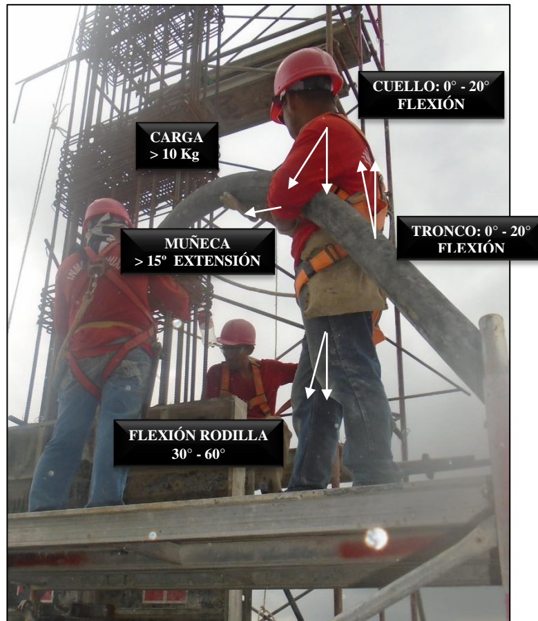
Foto 5. Fundición de columna.
