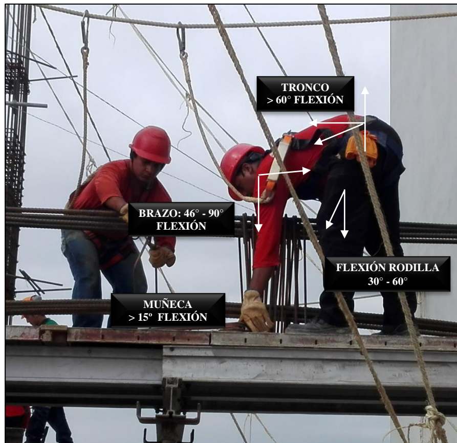
Foto 6. Armado de fondo de viga y estructura de hierro corrugado.
