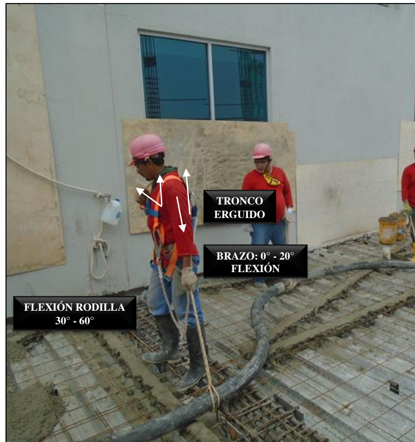
Foto 13. Fundición de losa.
