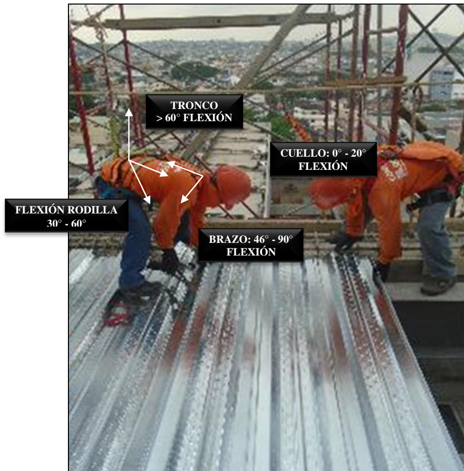
Foto 11. Montaje de planchas de metaldeck.
