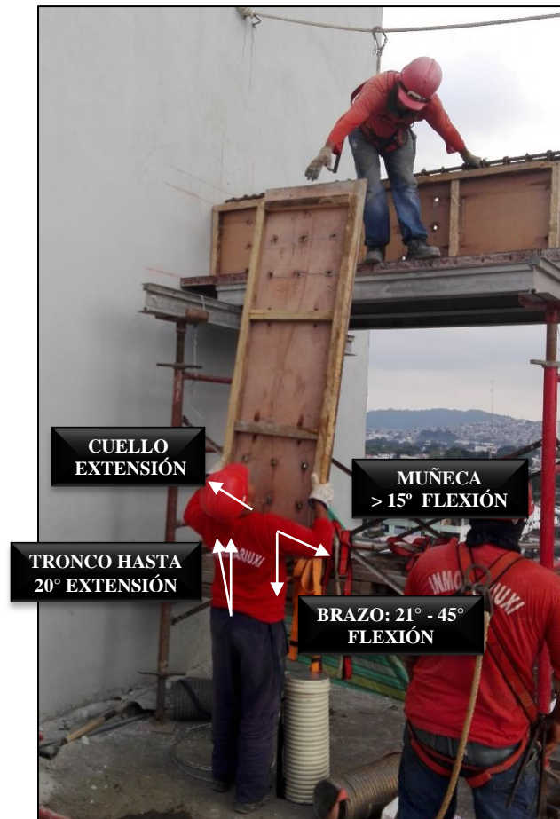
Foto 7. Encofrado de laterales de vigas.
