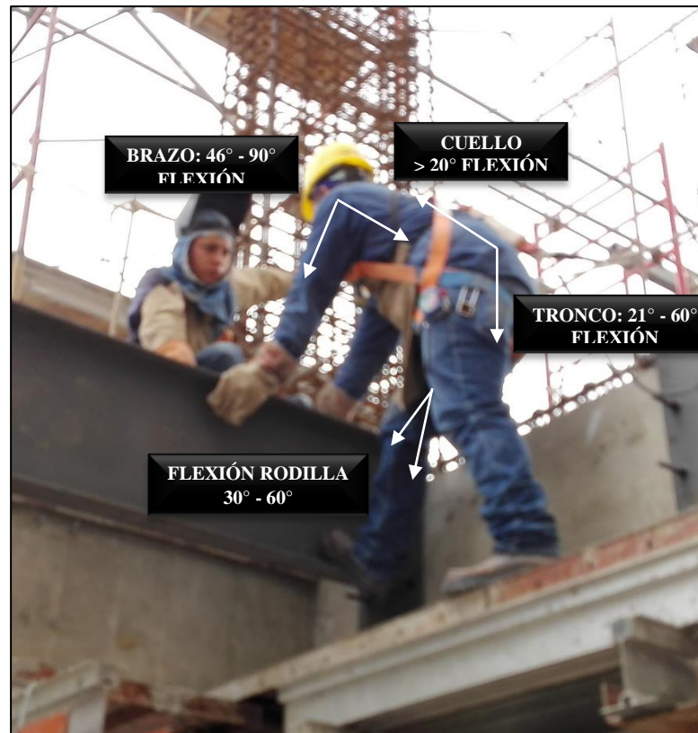
Foto 10. Montaje de vigas metálicas.
