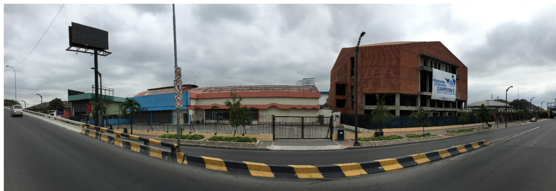
VISUAL EXTERIOR – AV. KENNEDY
