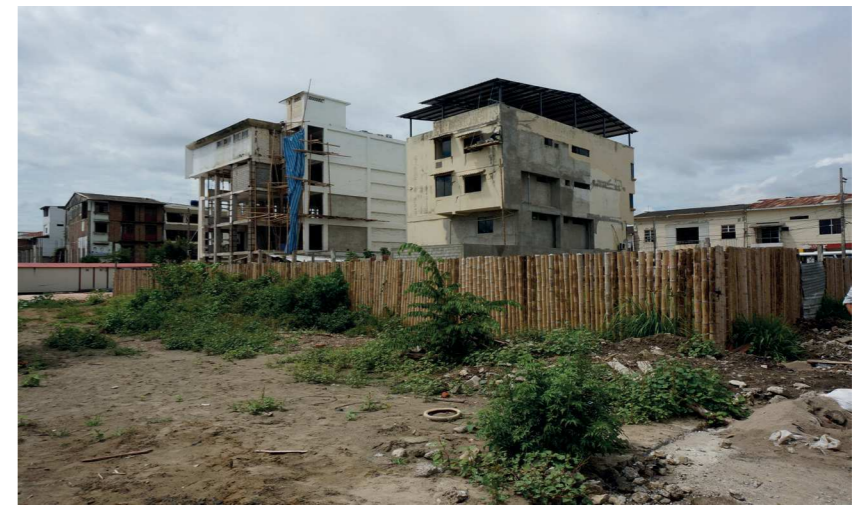
4. Vista interior terreno a calle Montufar
