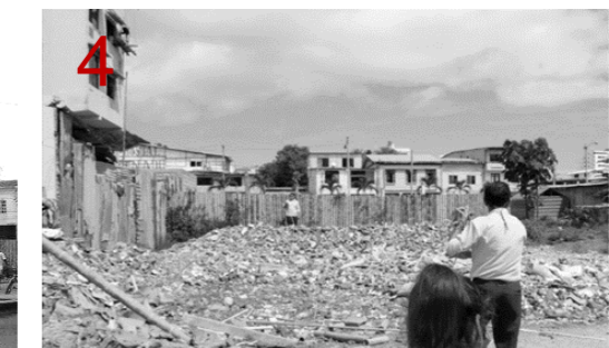
Figura 9 Vista interior del terreno Autor: Elaboración propia
