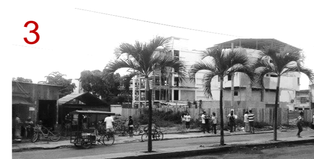
Figura 8 Vista oeste del terreno Autor: Elaboración propia
