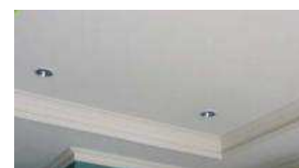
Figura 82: tumbado de gypsum Fuente: Construx (2014)
