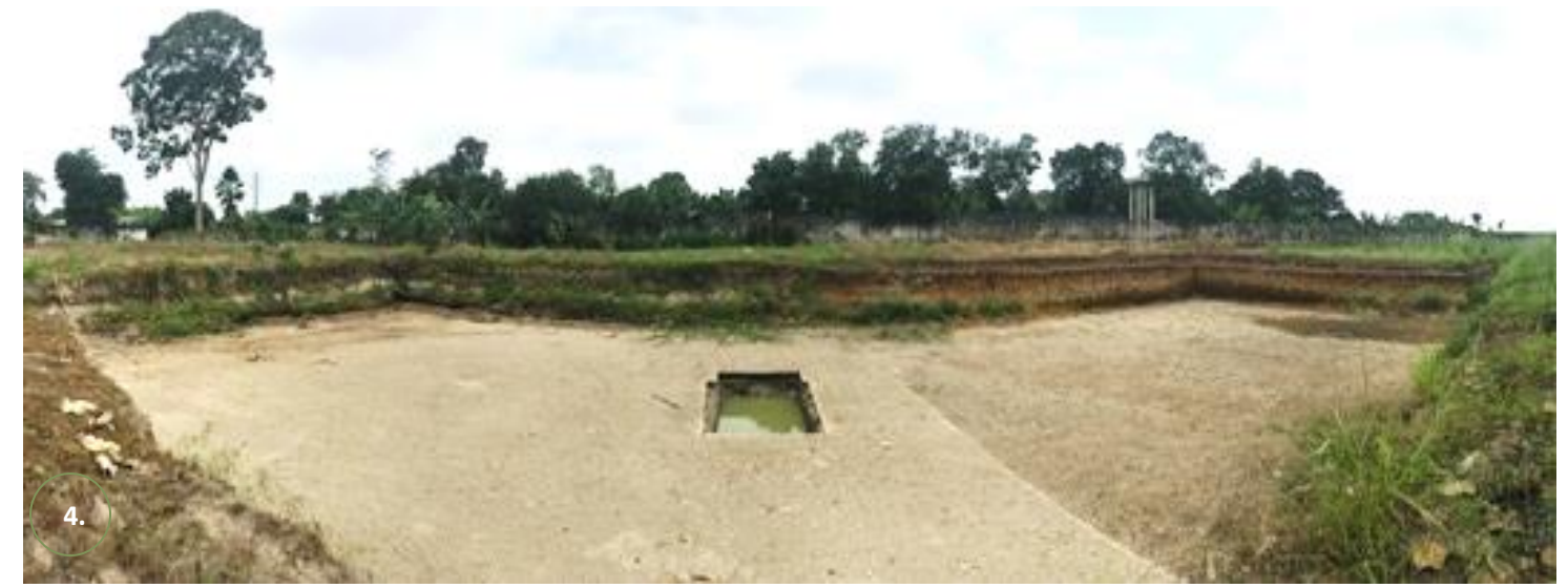
Imagen 12. Vista de excavación al interior del terreno
