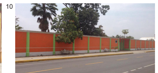
Figura 12. Cerramiento de terreno Autor: Bravo 2017
