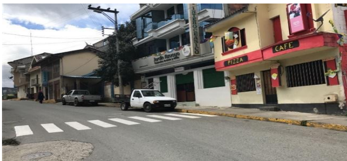
Figura 20: Viviendas del cantón Sevilla de Oro tomada por Gina González, tomada el 26 de noviembre del 2016
