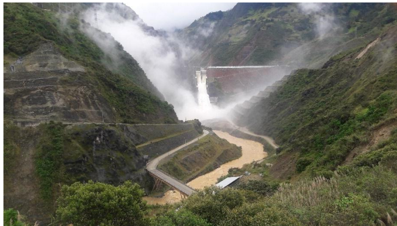
Figura B2: Camino a la Hidroeléctrica Mazar-Dudas, tomada por Gina González el 24 de junio del 2016
