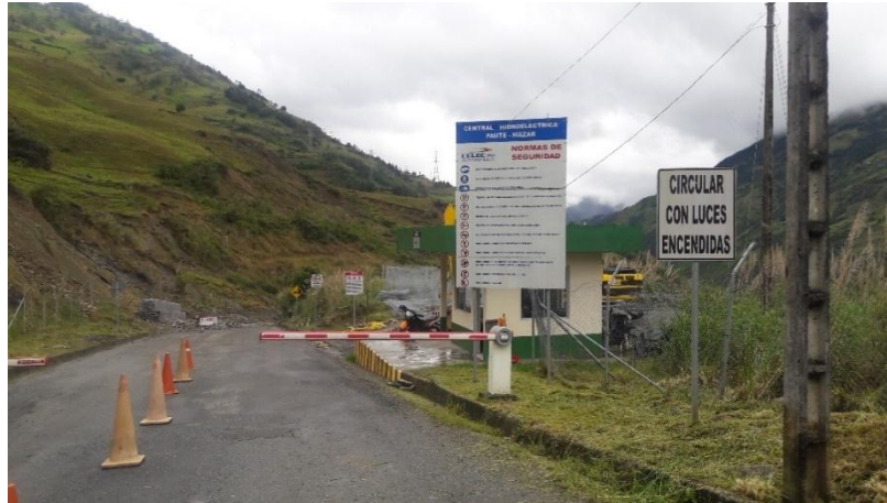
Figura B1 : Entrada a la Hidroeléctrica Mazar-Dudas, tomada por Gina González el 24 de junio del 2016
