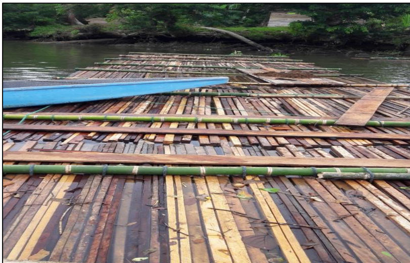
Figura 23. Construcción de balsas
