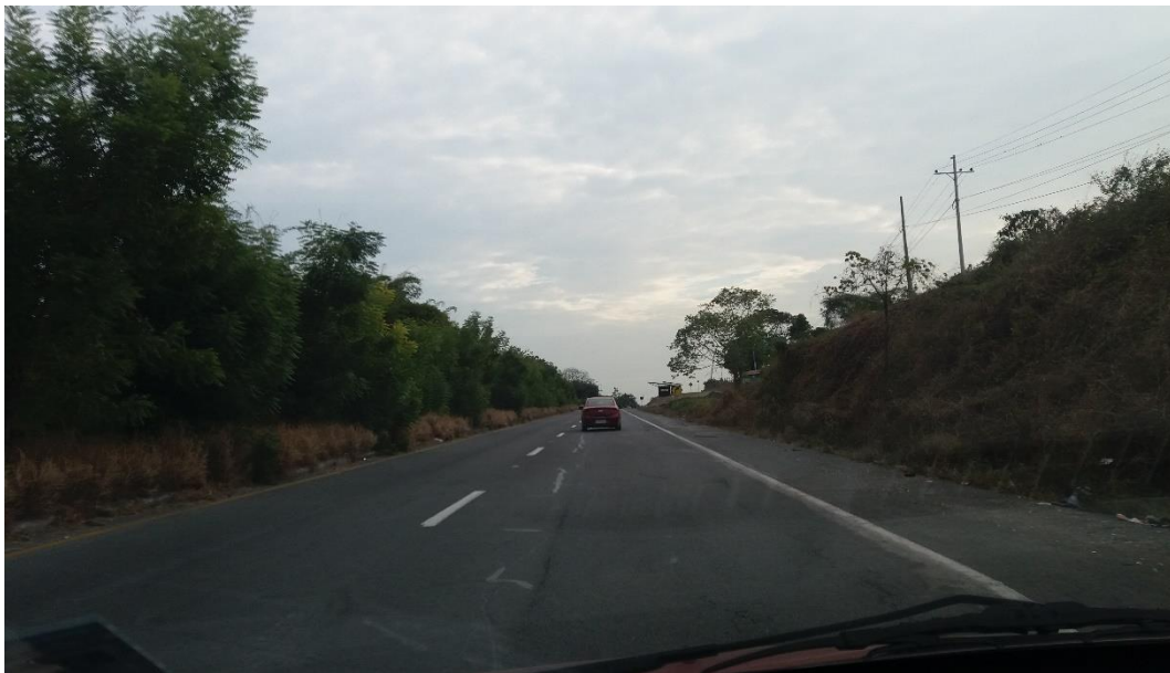
Figura 3. 2: Red eléctrica en vía Guayaquil – Salinas kilómetro 35. Elaborado por: Autor
