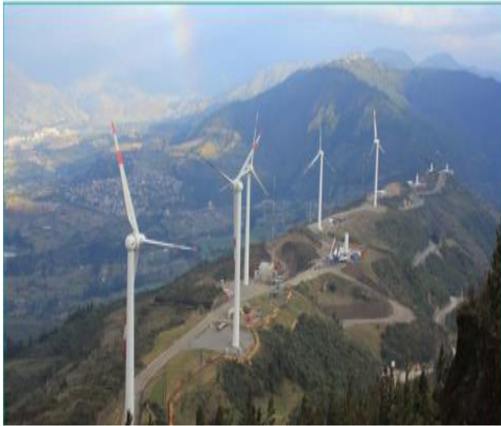
Figura 3. 3: Parque eólico Villonaco Fuente: (ARCONEL, 2017)
