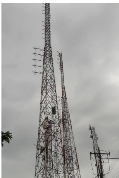
Figura 2. 20: Torres de comunicación Fuente: Autor
