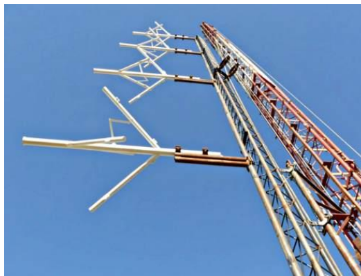
Figura 2. 19: Arreglos de antenas de radio FM
