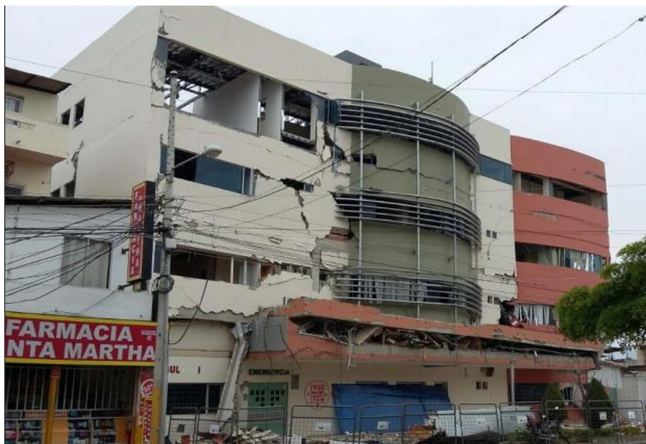
Figura 3.- Impacto losa contra losa producido por el terremoto Pedernales 2016 en la ciudad de Portoviejo
