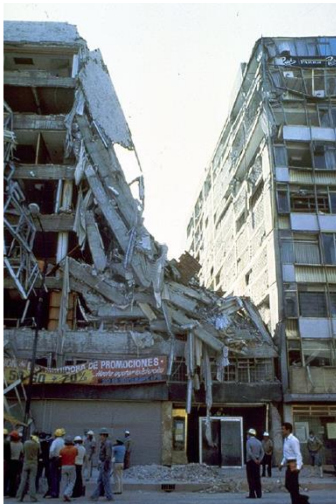
Figura 10.- Colapso parcial en una estructura debido al choque
