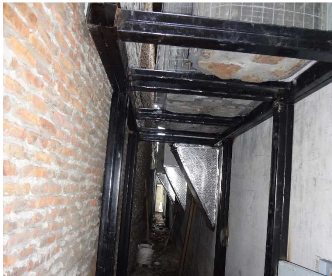
Figura 35. Estructura metálica Fuente: Iglesia Bautista Huerto del Gethsemani.
