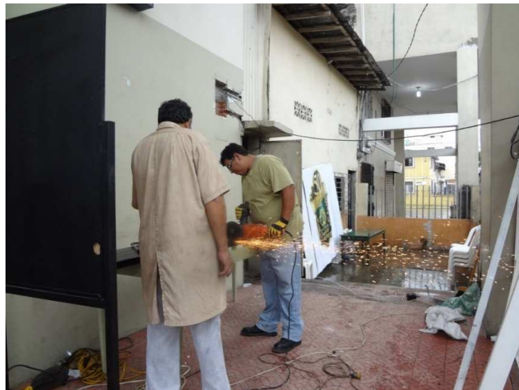
Figura 42 Trabajos realizados en el exterior - Climatización Fuente: J. Peralta, 2017
