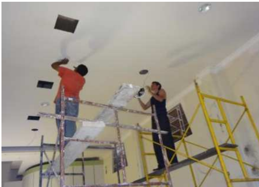
Figura 27 Colocación de las lámparas ojo de buey 20w y las rejillas de Climatización Fuente: J. Peralta, 2017
