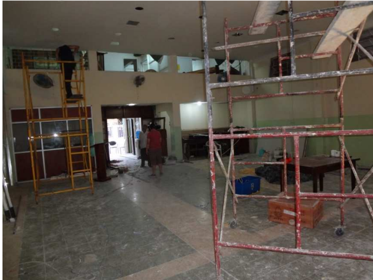
Figura 43 Instalación del gipsun - Climatización Fuente: J. Peralta, 2017
