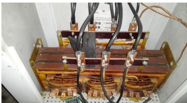
Figura 2.9 Vista interna de transformador 150 KVA Tipo seco Fuente: Envamet, 2017
