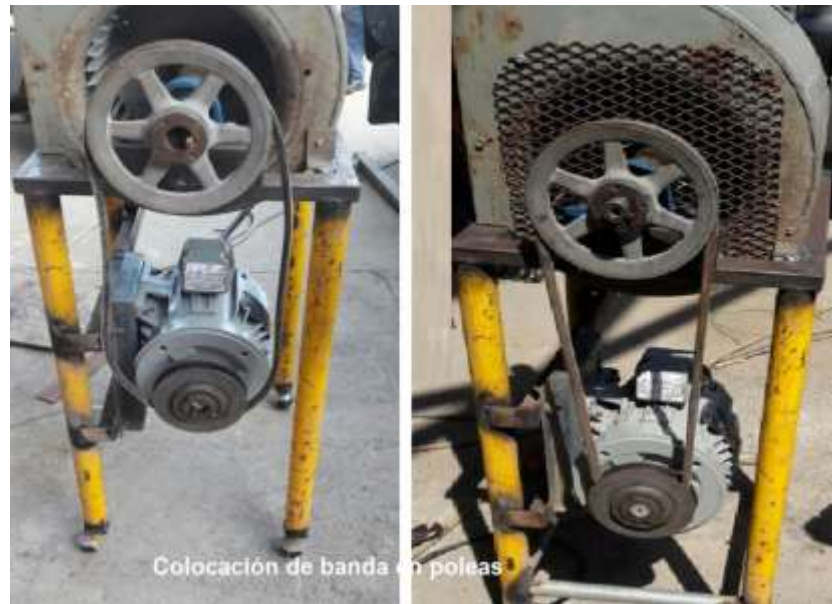
Figura 4. 5. Colocación de banda en las poleas
