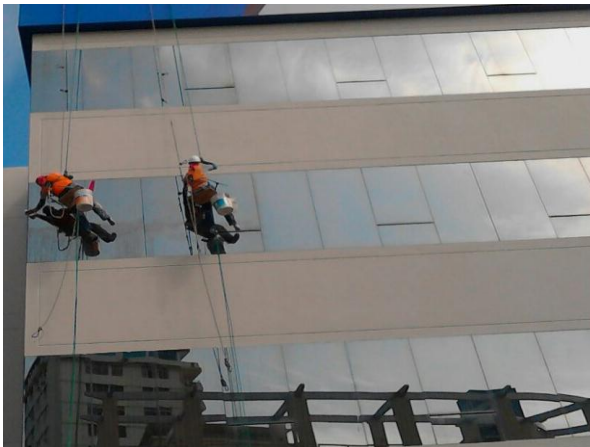
Figura 3: Limpieza de Fachada
