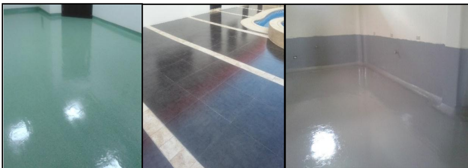
Figura 5: Aplicación de Selladores
