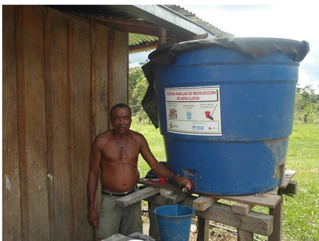
Figura 15. Tanques de recolección de aguas lluvias en Lago Agrio. Recuperado de: http://www.acnur.org/noticias/noticia/agua-de-lluvia-que-frena-la-contaminacion/
