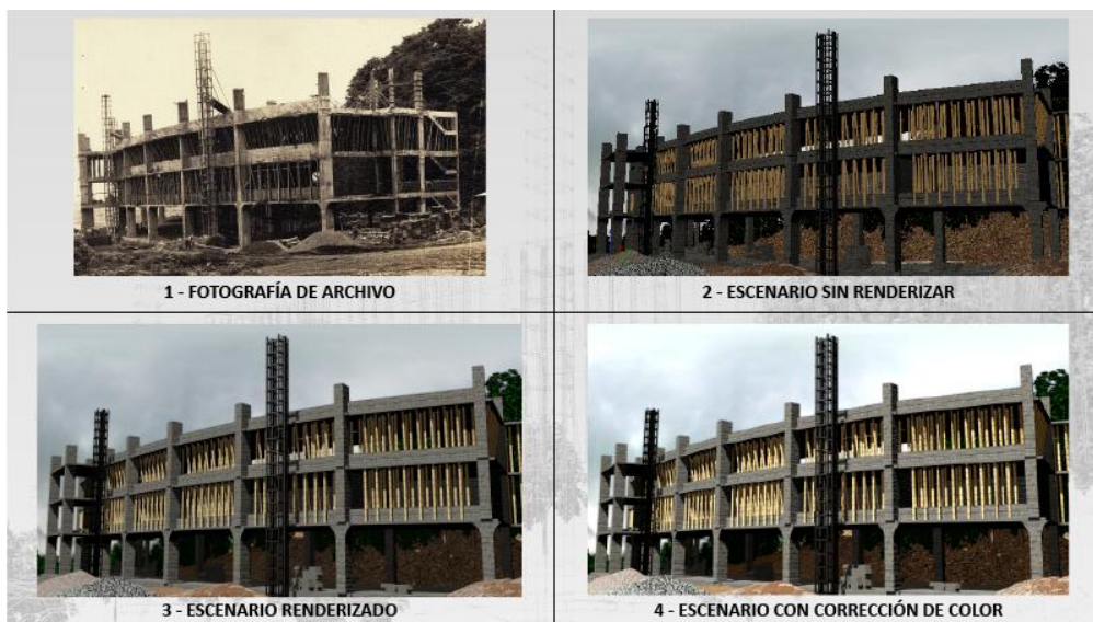
Gráfico 4-10: Reconstrucción del Edificio Principal (Toma 2, Etapa 1)
