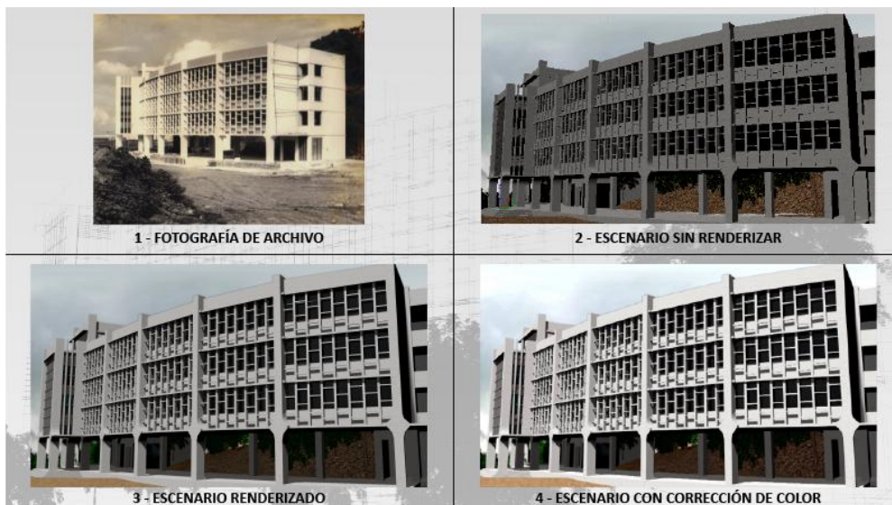
Gráfico 4-11: Reconstrucción del Edificio Principal (Toma 2, Etapa 2)
