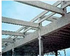
Gráfico 174: Vigas de hormigón armado.
