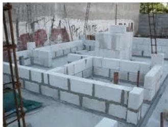
Gráfico 176: Alzado de bloques de hormigón.
