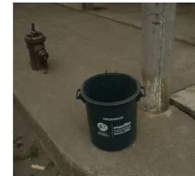
Ilustración 52 EXTERIORES E INTERIORES AGUA POTABLE DEL HOSPITAL
