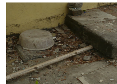
Ilustración 55 INTERIORES RED DE ALCANTARILLADO DEL HOSPITAL
