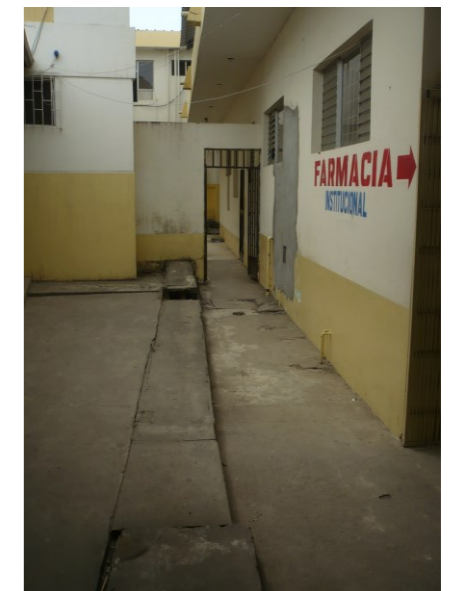
Ilustración 54 INTERIORES RED DE ALCANTARILLADO DEL HOSPITAL
