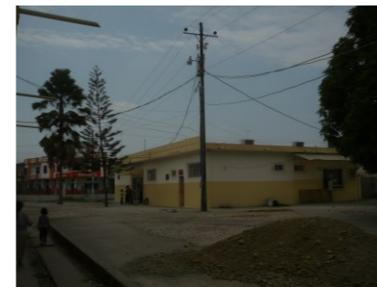
Ilustración 48 EXTERIORES E INTERIORES ALUMBRADO PÚBLICO DEL HOSPITAL
