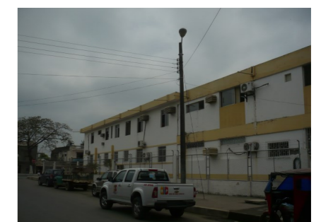
Ilustración 49 EXTERIORES E INTERIORES ALUMBRADO PÚBLICO DEL HOSPITAL
