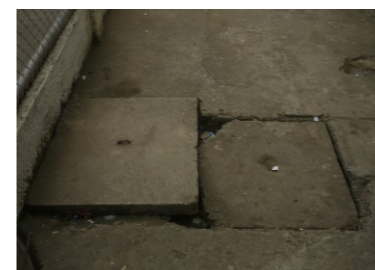
Ilustración 58 INTERIORES RED DE ALCANTARILLADO DEL HOSPITAL
