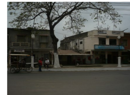
Ilustración 47 EXTERIORES E INTERIORES ALUMBRADO PÚBLICO DEL HOSPITAL
