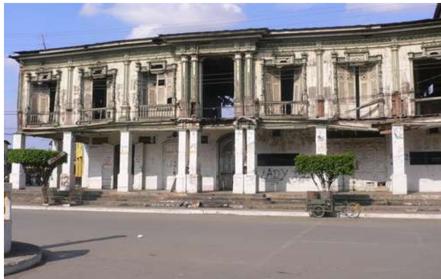
Ilustración 72 : Antiguo edificio municipal deteriorado año 2009
