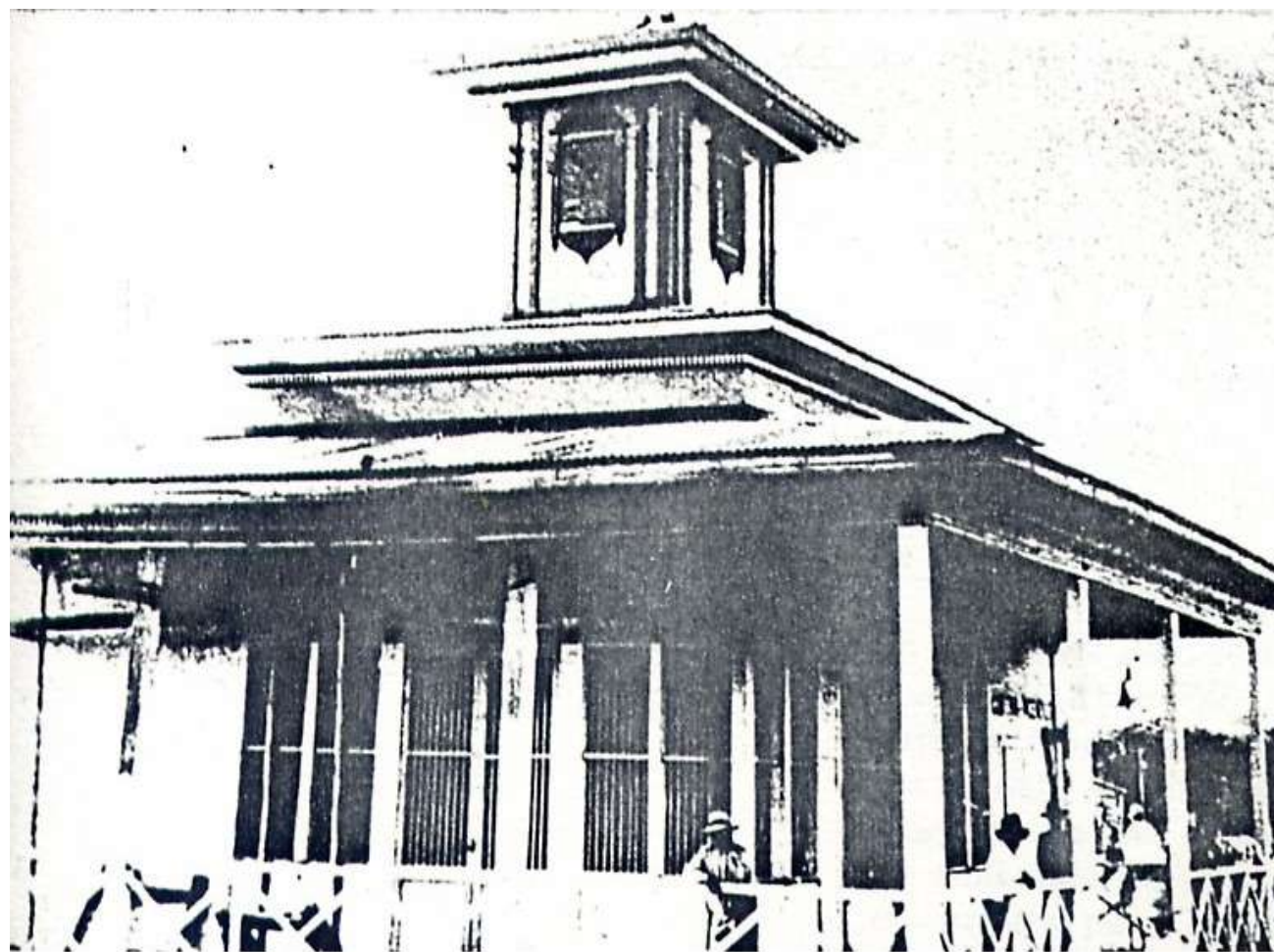
Ilustración 9: Deposito de la Bomba Vinces
