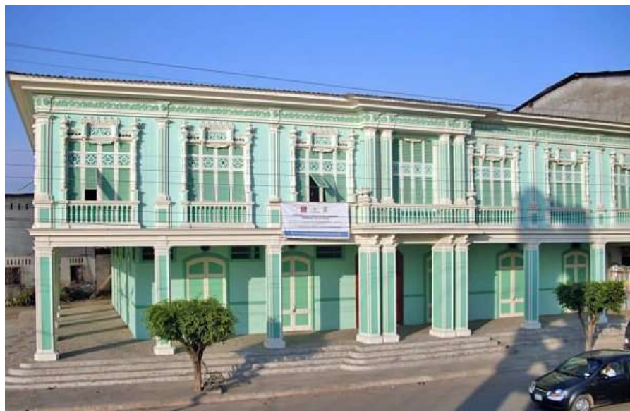
Ilustración 75 : Antiguo edificio municipal remodelado año 2012
