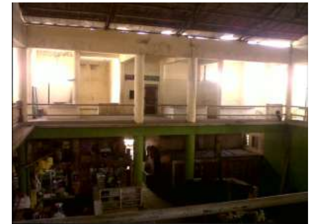
Ilustración 54 Vista general de las oficinas del Municipio – Planta alta del Mercado Central de San Lorenzo de Vinces. Fuente: Foto tomada por Grupo de Tesis TALLER XVI- Diciembre 2011.
