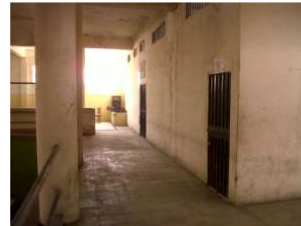
Ilustración 53 : Departamento de visitador social, sala de operaciones y maquinarias y agrícolas. Oficinas del Municipio – Planta alta del Mercado Central de San Lorenzo de Vinces. Fuente: Foto tomada por Grupo de Tesis TALLER XVI- Diciembre 2011.
