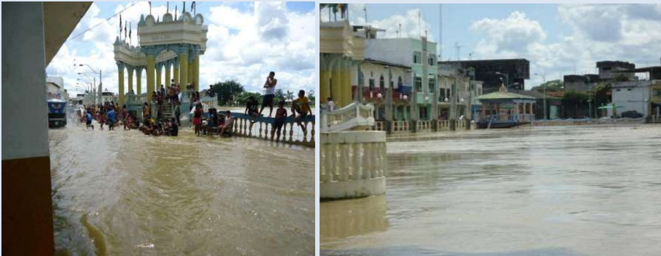
Ilustración 20 : Deterioro del Malecón de Vinces por las lluvias. Fuente: Foto diario la Hora, visitado 7 de junio 2012
