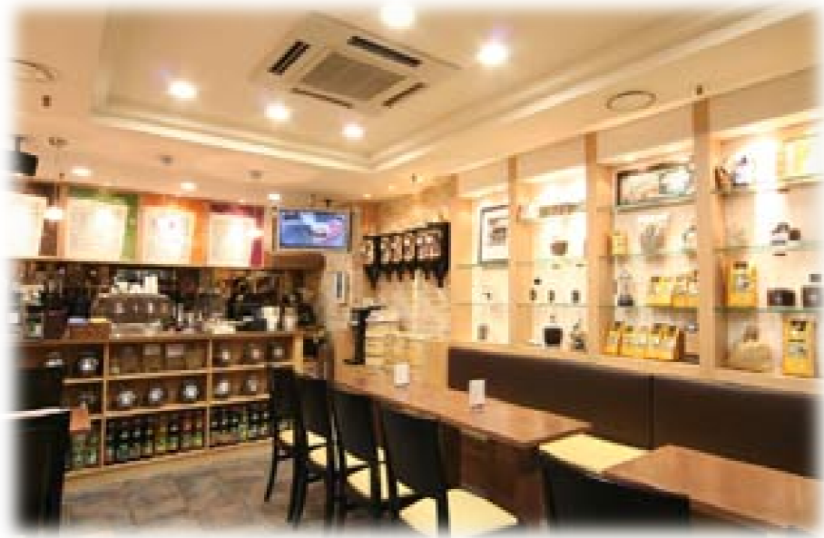
Imagen # 109: Iluminación Cafetería
