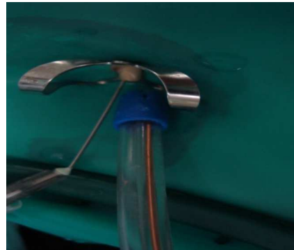
Fig. No. 8.19 Desinfectado y lavado del conducto. Fuente: John J. Párraga Mera.
