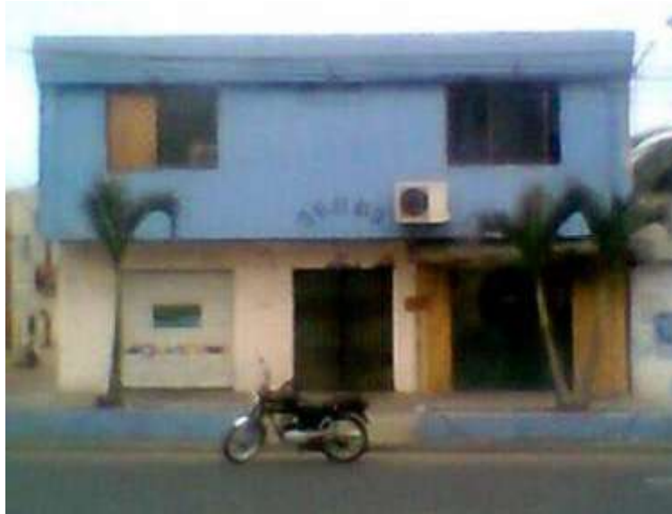
Ilustración 16 . Frente de las Instalaciones del centro artesanal
