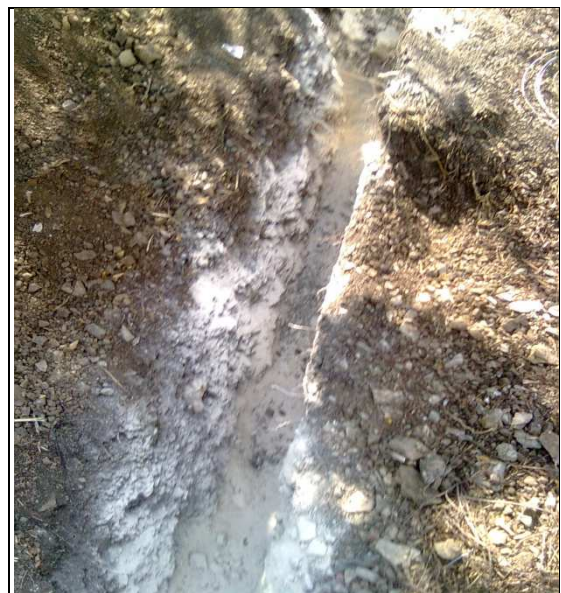
CUBRIMIENTO DE CABLE CON MEJORADOR DE CONDUCTIVIDAD
