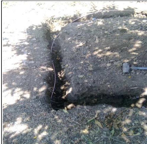
INSTALACIÓN DE CABLE 2/0
