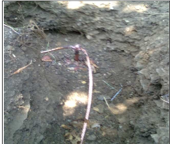
SOLDADURA EXOTERMICA VARILLA 5/8 CABLE CU 2/
