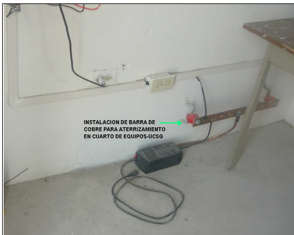
Figura 6.1 Barra de aterrizamiento para equipos electrónicos
