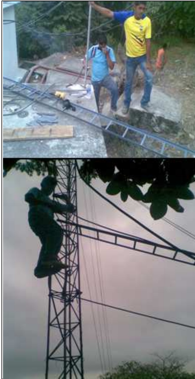
Figura 5.10 Construcción e instalación de bajante o escalerilla para cables RF
