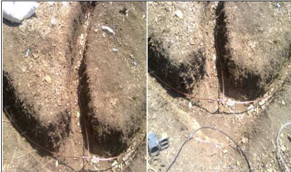
Figura 5.2 Excavación para 3 electrodos de sistema tierra-torre
