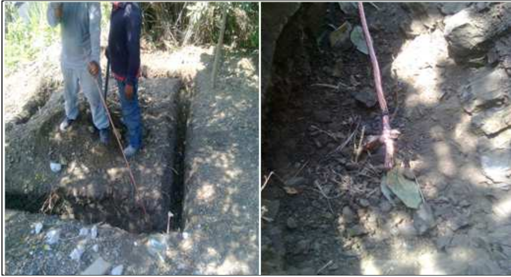
Figura 5.1 Excavación para malla de conductores de cobre del sistema de tierra
