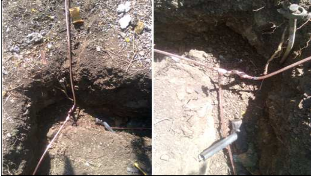
Figura 5.4 Soldadura exotérmica en electrodos
