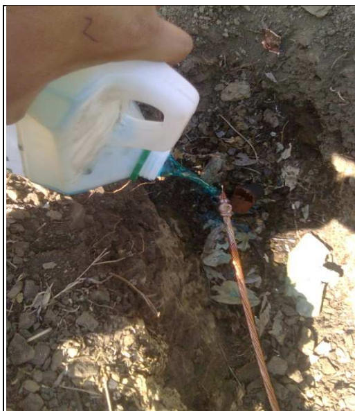
AGREGADO ELECTROLITICO A CONECTORES
