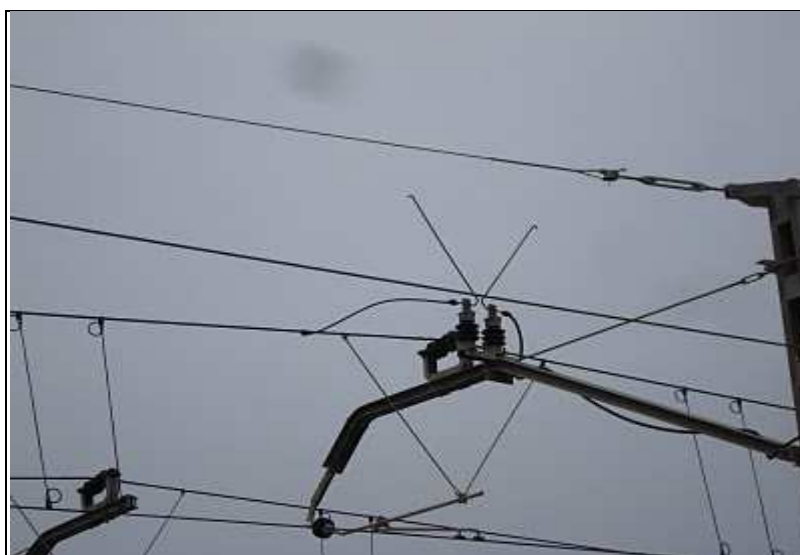
Figura 3.14 Pararrayo de cuernos en la catenaria
