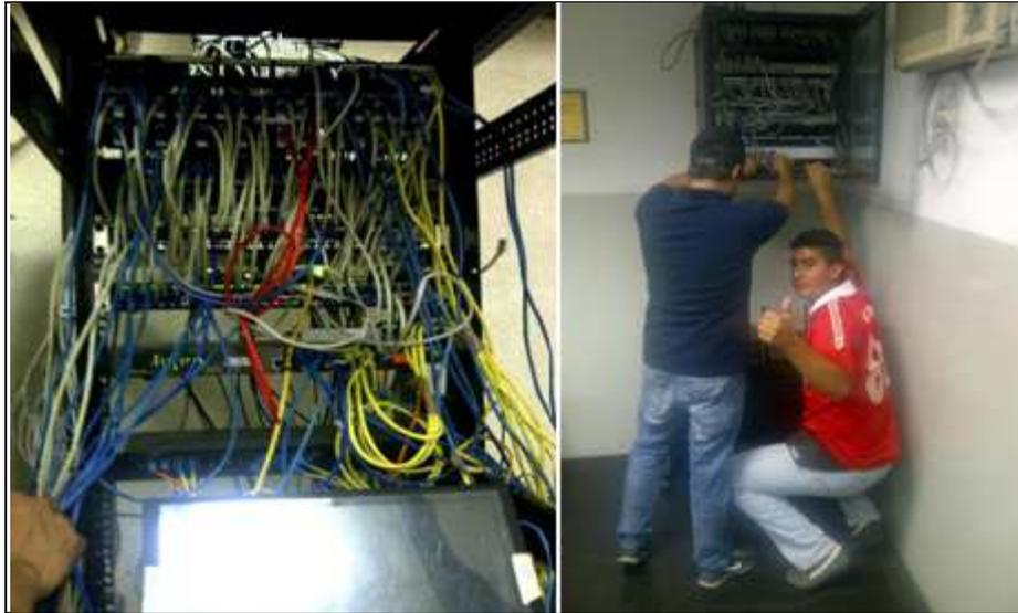
**Figura 4.12 Reordenamiento y rotulación en switches de la FI**
