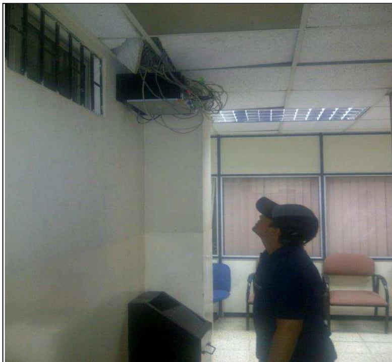
**Figura 4.1 Rack 2, con incumplimiento norma de acceso a rack**
