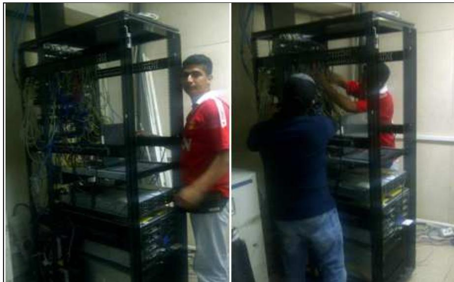
**Figura 4.9 Rack primario con mal ordenamiento de cables de red**
