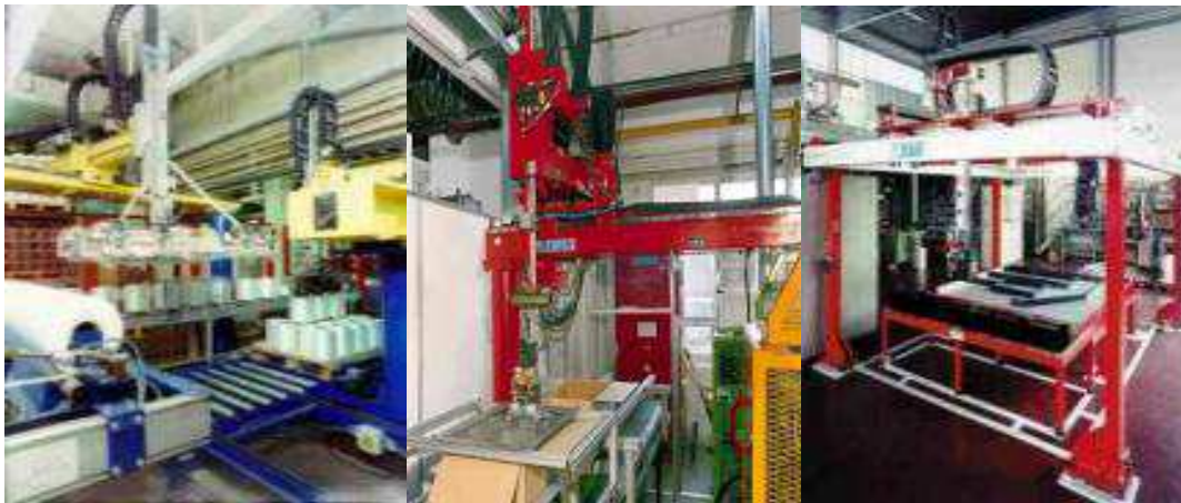
Figura 1.8: Operaciones de carga y descarga de máquinas.
