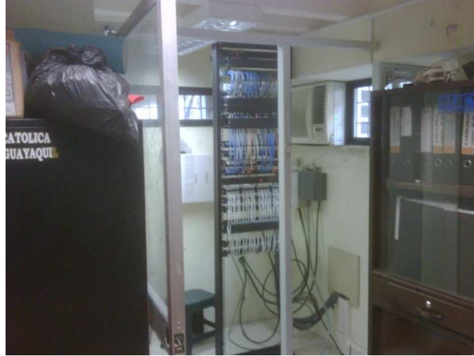
Figura 5.20 Instalación de las mamparas de vidrio
