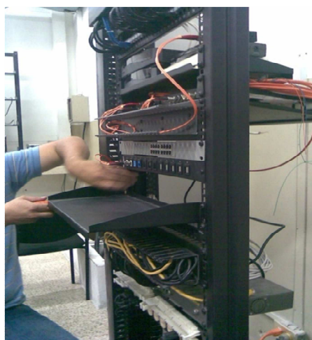
Figura 7.11 Instalación de bandejas
