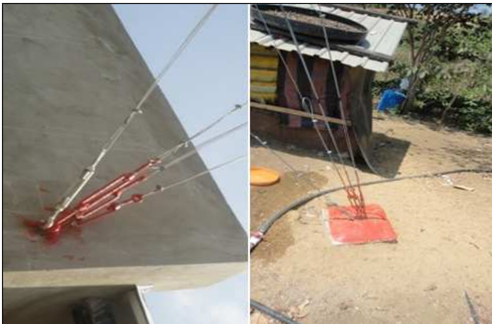
Figura 4.20 Vientos nuevos, anclajes y templadores para torre
