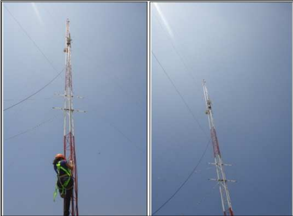
Figura 4.21 torre pintada por integrantes de la Tesis
