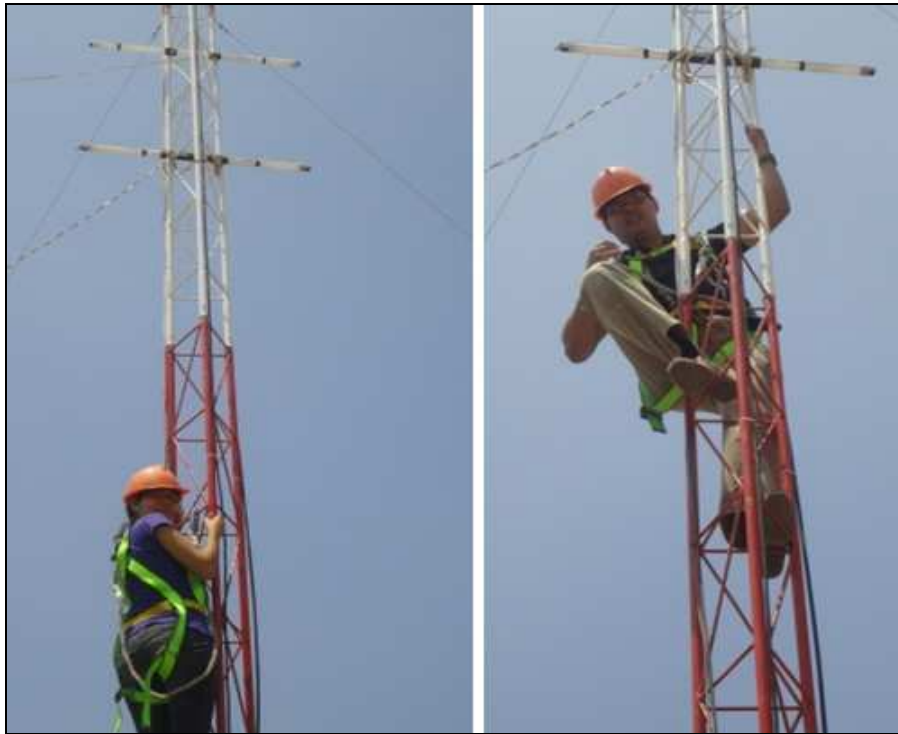
Figura 4.19 Ensamblando segmentos a torre de Telecomunicaciones
