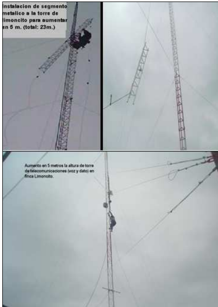
Figura 4.8 Aumento a 23 metros la altura de torre de telecomunicaciones
