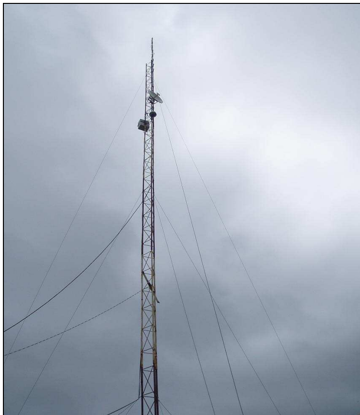
Figura 4.1 Torre de Telecomunicaciones de Limoncito
