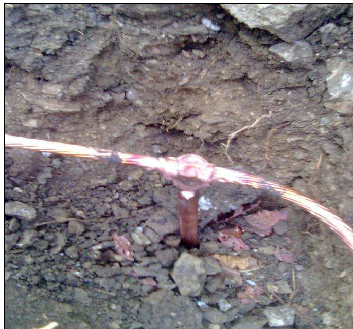
Figura 4.15 Soldadura exotérmica en conductores y electrodos
