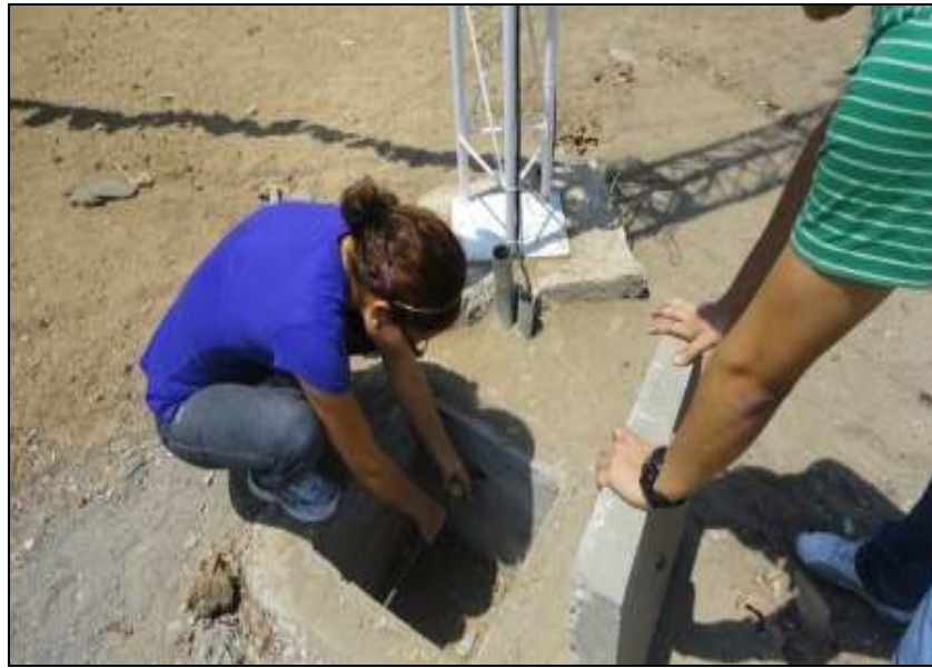
Figura 4.23 Revisando conexión a sistema tierra de la torre
