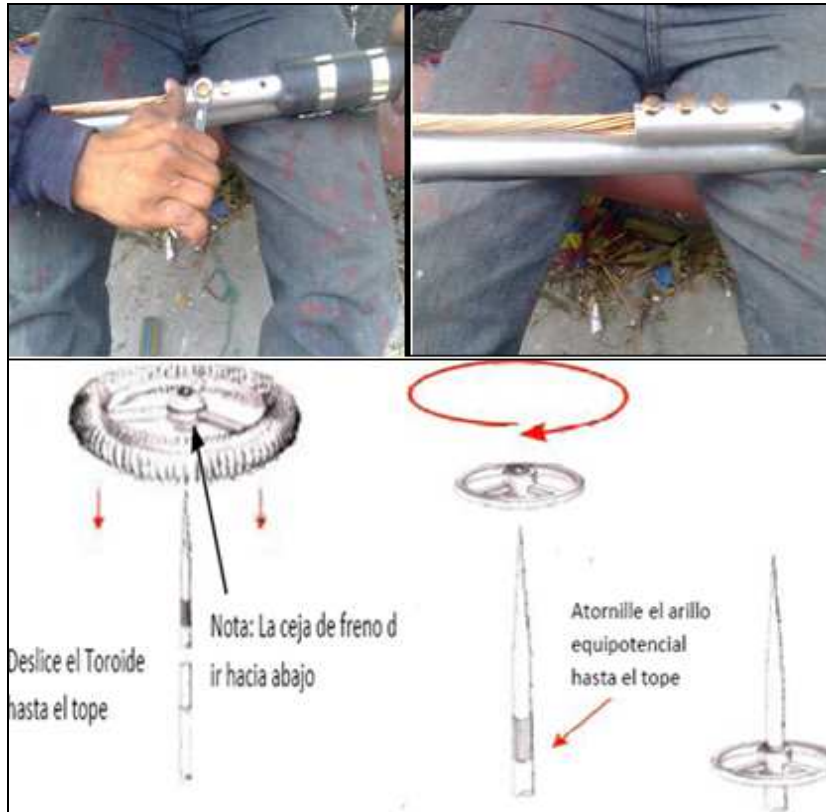
Figura 4.10 Armado del Pararrayo
