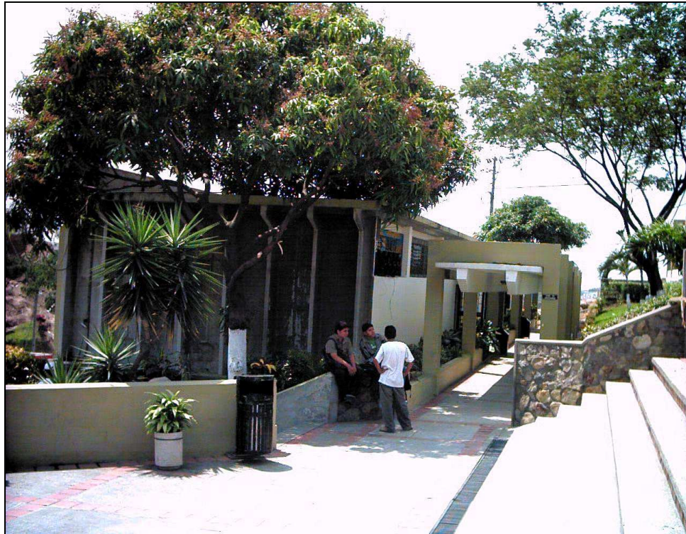
Figura 4.2 Monitoreo a laboratorios de Electrico-Mecanica y Telecomunicaciones
