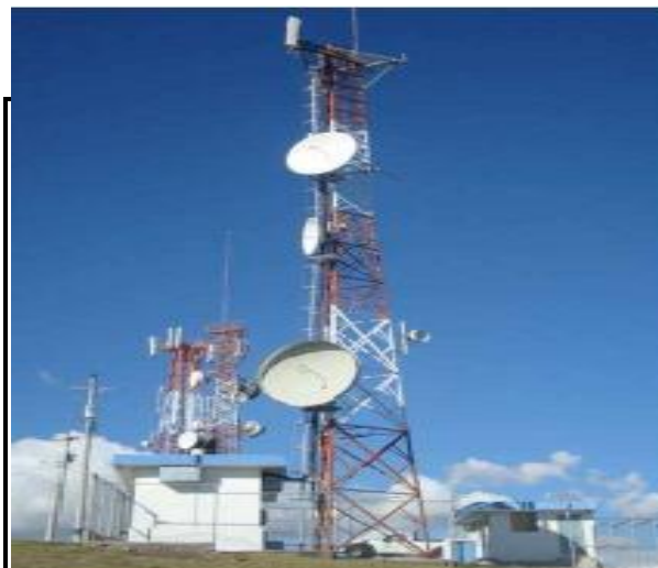
Figura 1.24: Tipos de torres auto soportadas Fuente: los autores
