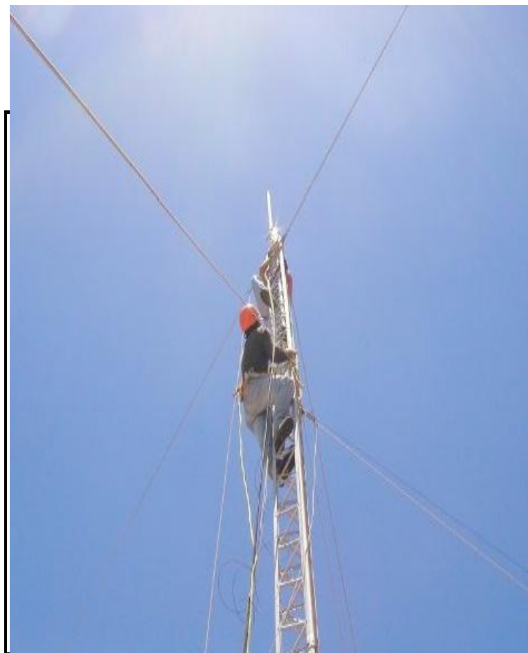
Figura 1.27: Instalación de Torre venteada Fuente: los autores
