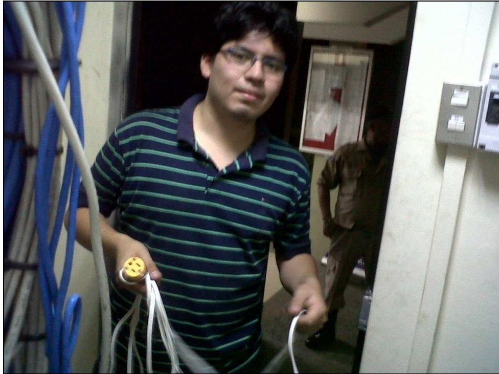
Figura 7.15 Instalación del sistema eléctrico dentro del cuarto de rack de la Facultad Técnica por parte de nuestro compañero Franklin Freire.
