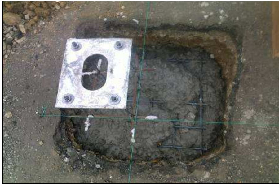
Figura 5-3 Obra civil para colocar la base de las torres de las barreras
