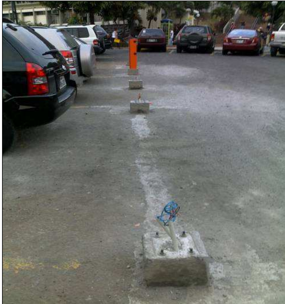
Figura 5-5 Base de concreto para las barreras vehiculares
