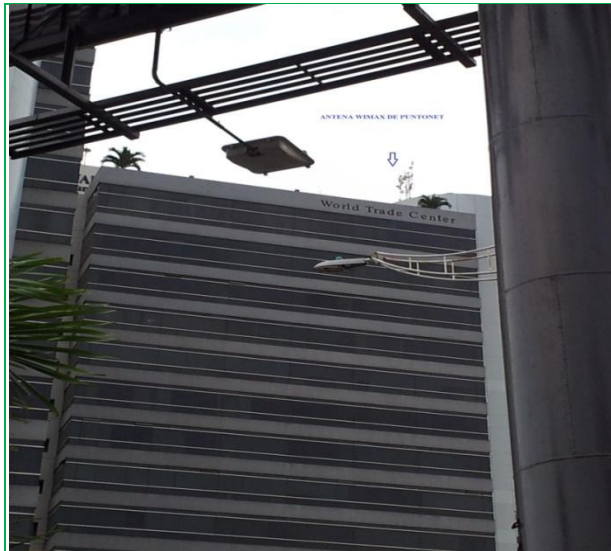
Figura 3.18 Edificio WTC, Oficina Puntonet y ubicación de Transmisor Wimax
