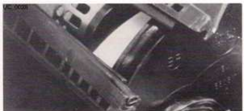
Figura 4.39: Colocando el cordón de junta
