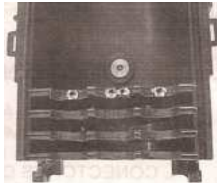
Figura 4.7: Instalación de las chapas antitracción
