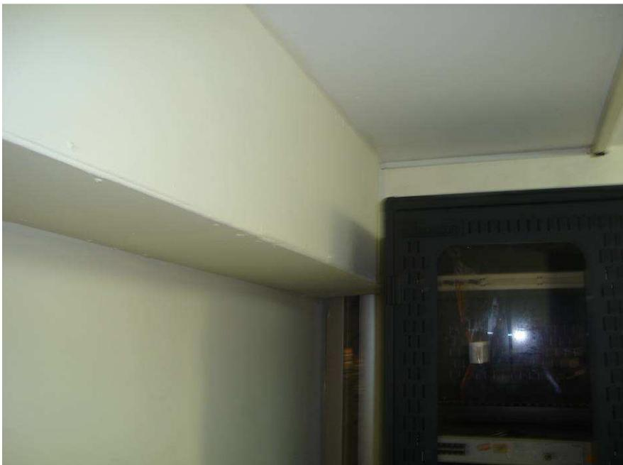
**Figura 3.20: Vista del ducto de AA.CC. resanado**
