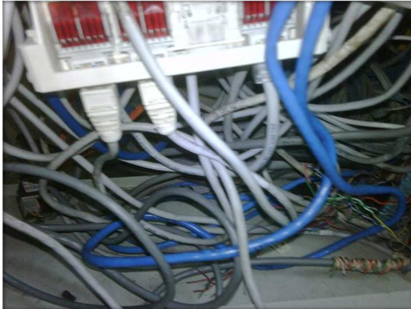
**Figura 3.5: Estado del cableado interno del rack**
