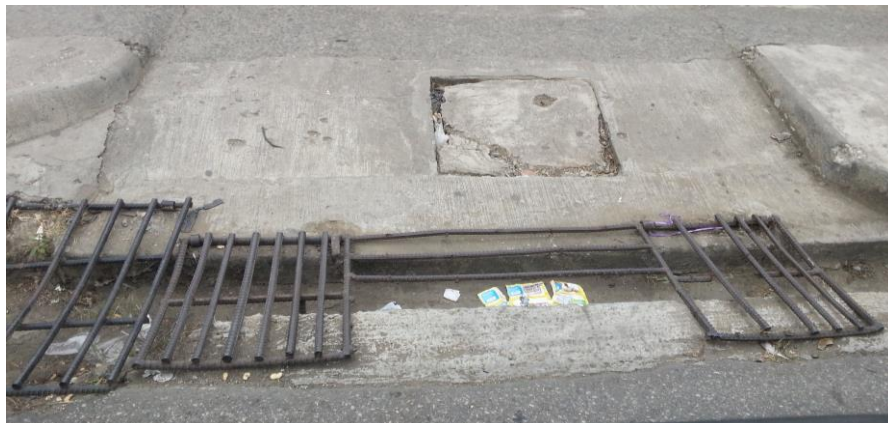
Cuneta Calle Ilanes
