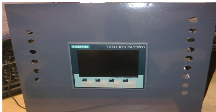
Figura 4.23: Vista frontal del montaje del equipo de medición, orificios panel frontal Fuente: Autores del documento
