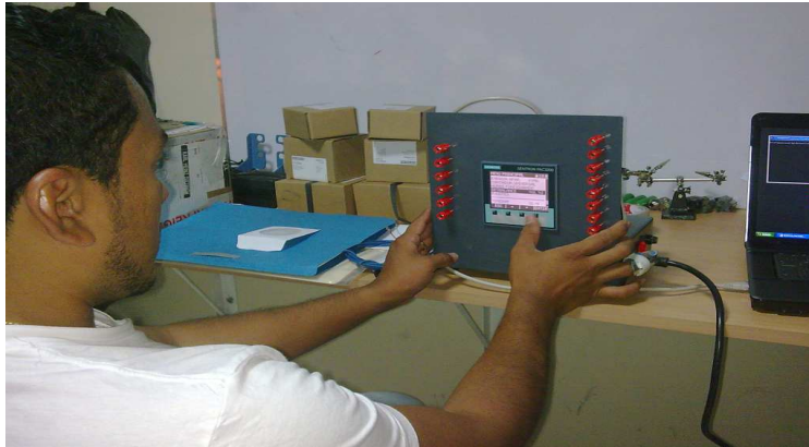
Figura 4.28: Pruebas de encendido y conexiones del sistema de supervisión (in – out) Fuente: Autores del documento
