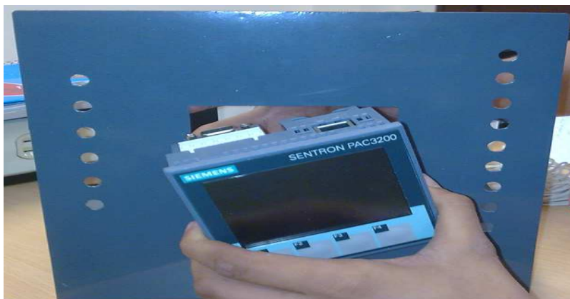
Figura 4.18: Montaje del equipo de medición Sentron pac, inserción en el panel frontal. Fuente: Autores del documento
