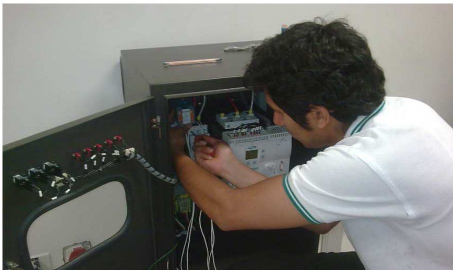
Figura 4.37: Transformador de corriente de 50 a 5 A con marquilla. Fuente: Autores del documento
