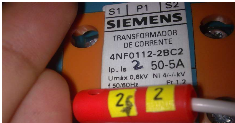
Figura 4.36: Transformador de corriente de 50 a 5 A con marquilla. Fuente: Autores del documento
