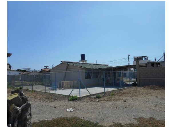
Figura 2: vista frontal, CIBV Fuente: elaboración propia
