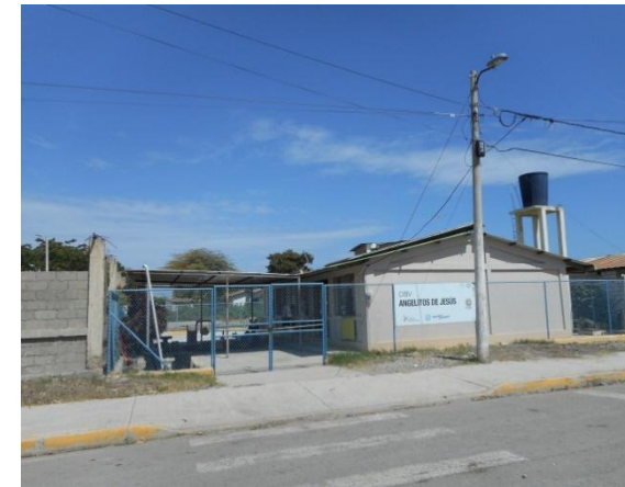
Figura 1: vista frontal, CIBV Fuente: elaboración propia
