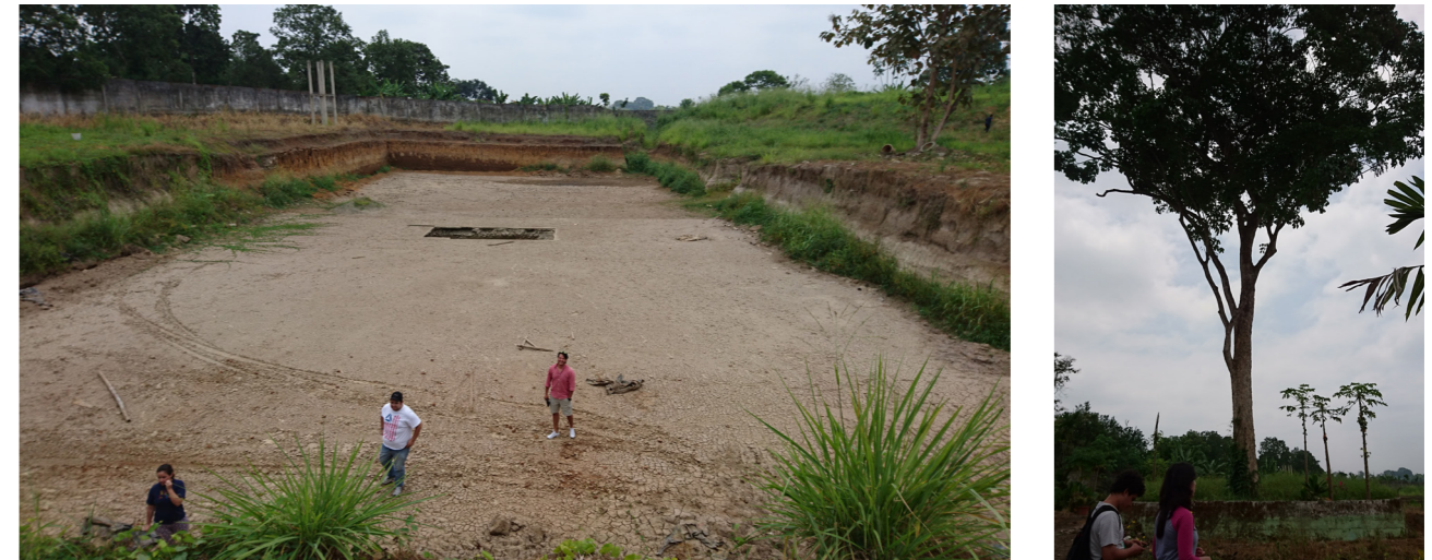
Figura 5: Fotografías del terreno. Excavación y Guayacán presentes. Fuente: Sánchez, Cristina (2016)
