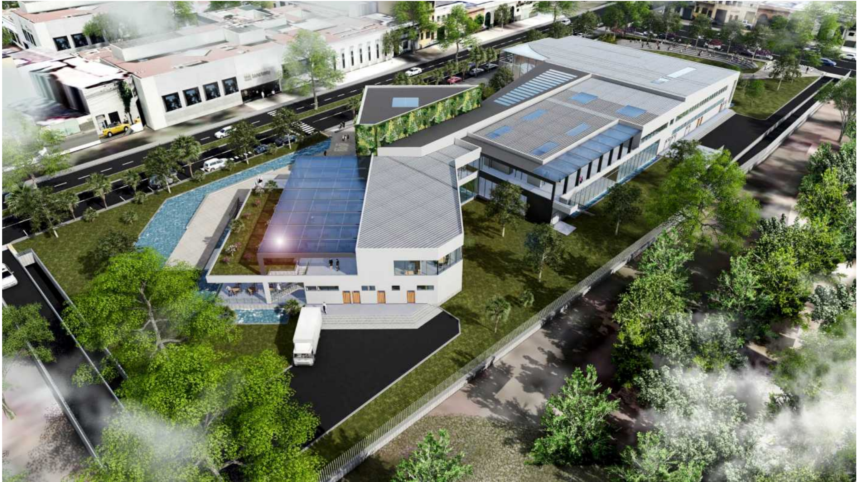
Fig. 23. Vista aérea Fachada Oeste.
